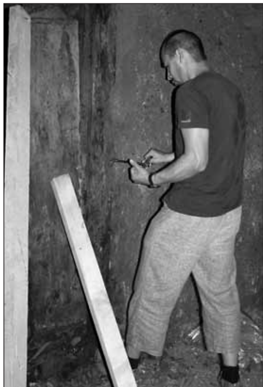
Obr. 14 Ilustrační záběr na odebírání dendrovzorků z dřevěné konstrukce zárubní vstupu do centrální komory krypty (foto Archaia Brno o. p. s. – i. č. 15074-2011).
