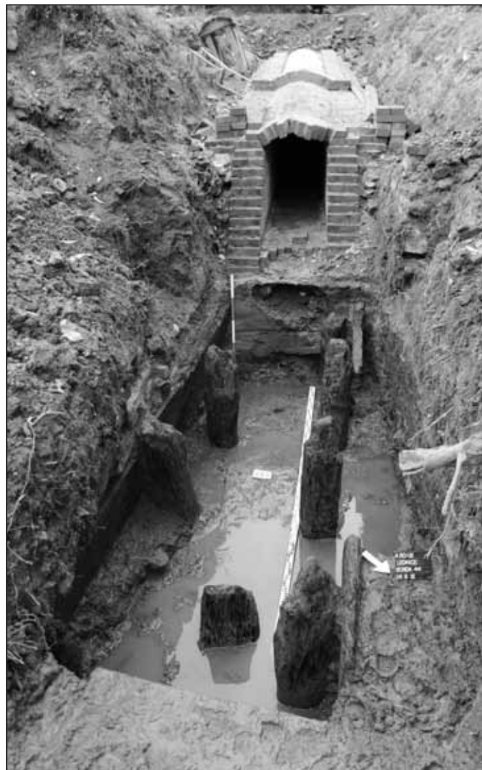
Obr. 12 Původní dřevěné odvodnění prostoru jízdárny, pohled od severu do sondy 44 (foto Archaia Brno o. p. s. 26995-2012).
