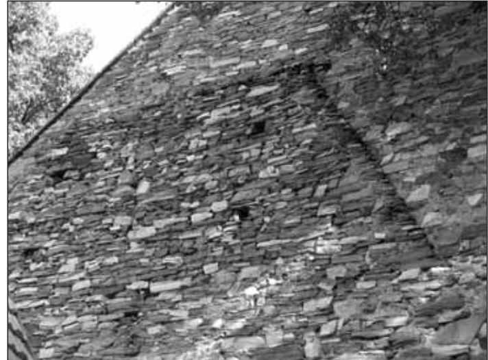
Abb. 7 Westfassade. Detail des Dachgiebels der ältesten Bauphase der Kirche.
