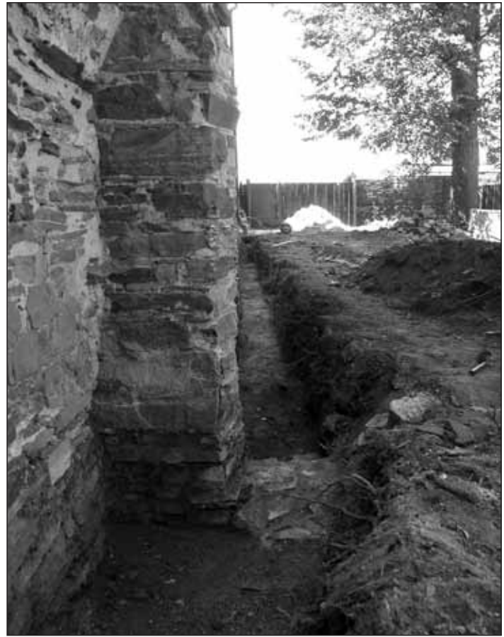
Abb. 15 Entfeuchtungsgraben an der Kirchenmauer.
