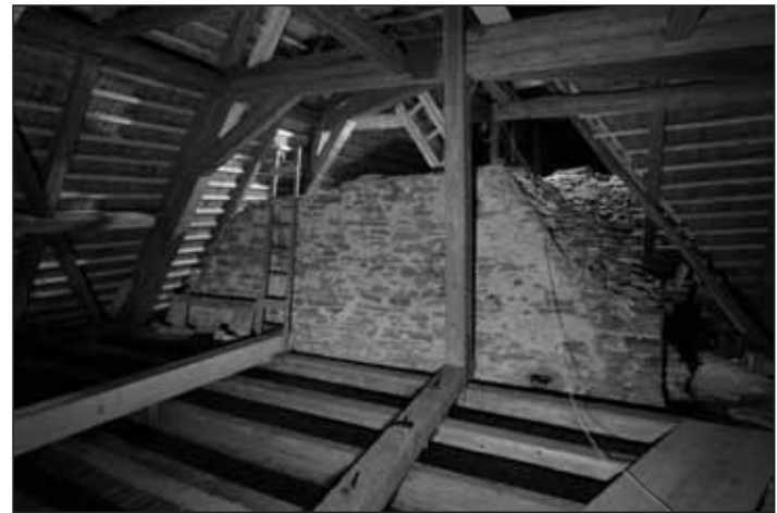
Abb. 11 Relikt der östlichen Giebelwand der ältesten Bauphase der Kirche im Dachgeschoss über dem Triumphbogen.
