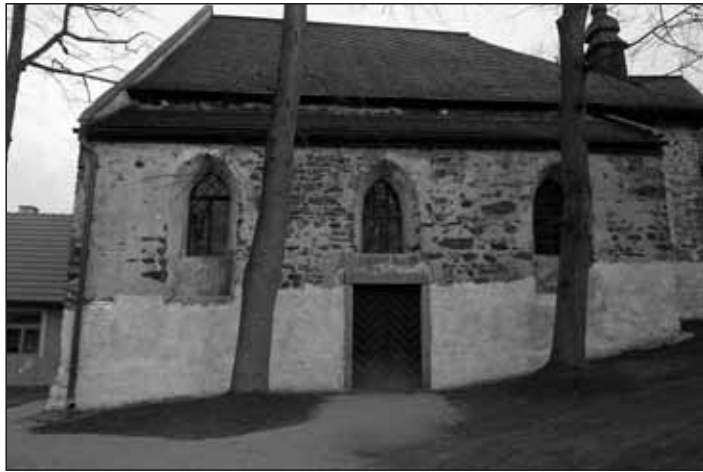
Abb. 8 Südwand des Kirchenschiffes. Blick von Süden.
