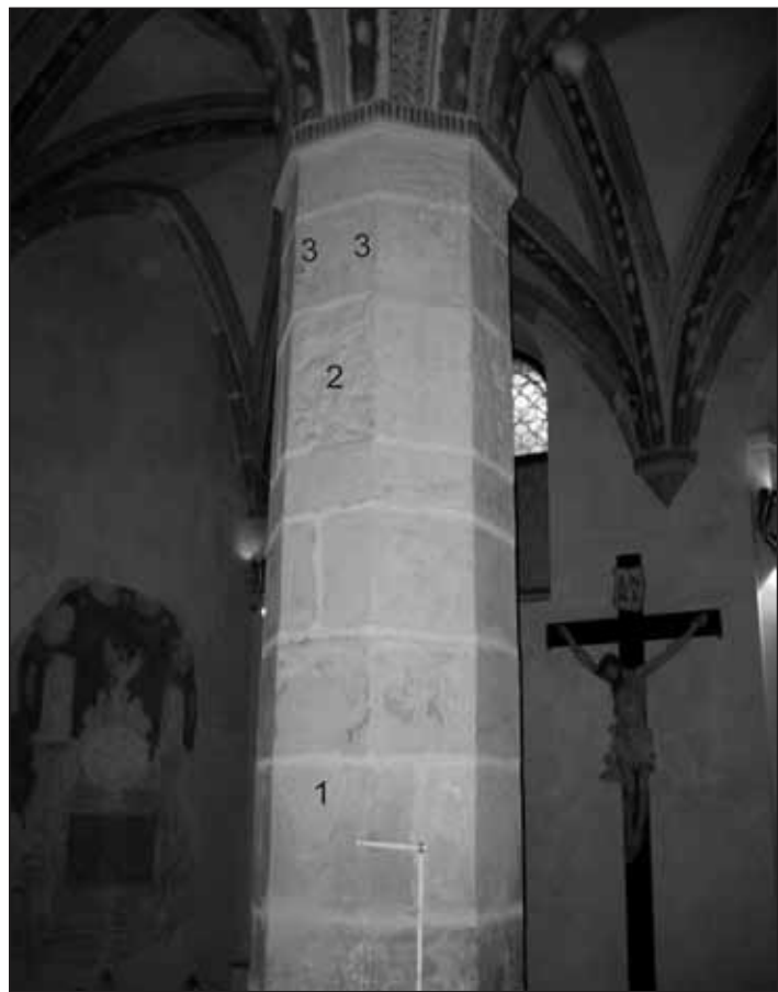
Obr. 9 Praha, Malá Strana. Kostel sv. Tomáše s klášteřem augustiniánů (čp. 28). Pohled na severní sloup klenby kapitulní síně. 1 – odsekaná konzola. 2 – odlámané baldachýny. 3 – jizva a zbytek nosíků po výběhu klenebních žebrových klínů.
