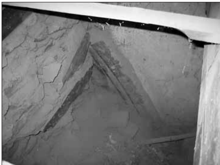
Obr. 10 Praha, Malá Strana. Kostel sv. Tomáše s klášteřem augustiniánů (čp. 28). Přízední žebro ambitu východního křídla (v severní části zdi).
