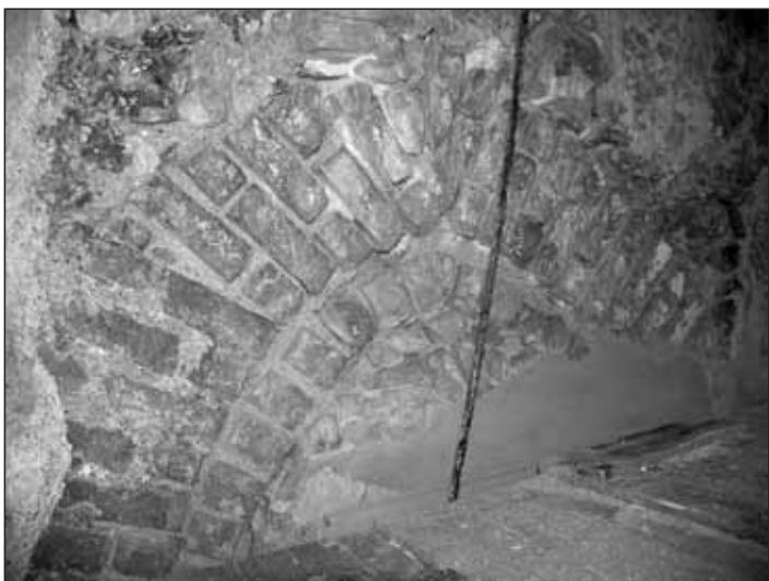
Obr. 11 Gotický lomený oblouk v úrovni 1NP severní fasády věže odkrytý r. 2007. Foto archiv Archaia Brno o. p. s. 2007, i. č. 09065-2007.
