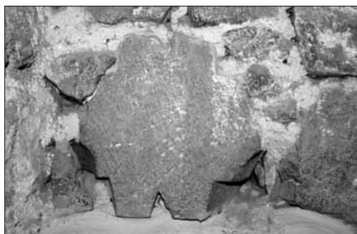
Obr. 21 Kamenický článek zazděný v interiérovém líci 4NP věže. Foto archiv Archaia Brno o. p. s. 2013, i. č. 19963-2013.
