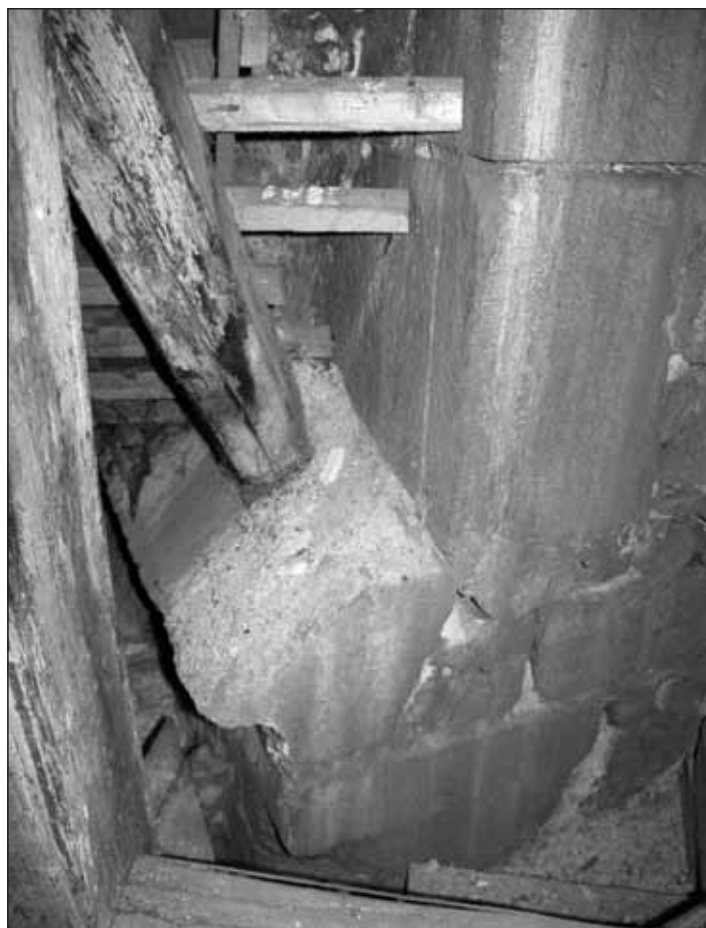
Obr. 22 Detail římsy jihozápadního opěráku patrně v podkroví Lorety. Foto archiv Archaia Brno o. p. s. 2013, i.č. 19917-2013.
