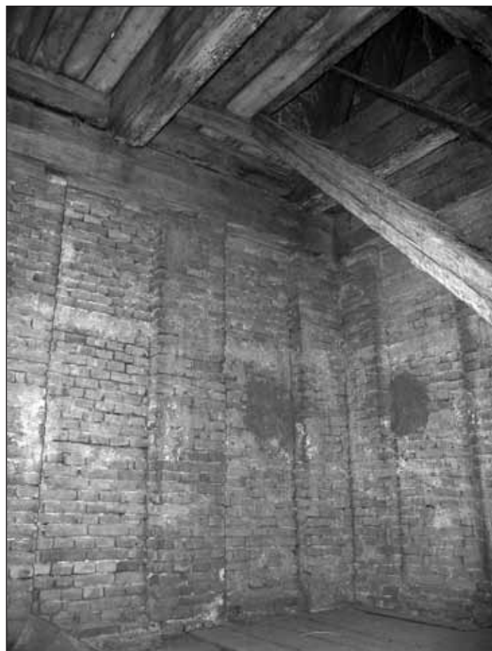
Obr. 23 Přízední pilíře v interiéru barokní nástavby věže – 5NP. Foto archiv Archaia Brno o. p. s. 2013, i. č. 19864-2013.
