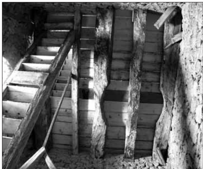
Obr. 18 Strop 3NP s manipulačním otvorem pro zvon. V nárožích patrné pozůstatky lešení datovaného k roku 1367/68. Foto archiv Archaia Brno o. p. s. 2013, i. č. 19846-2013.
