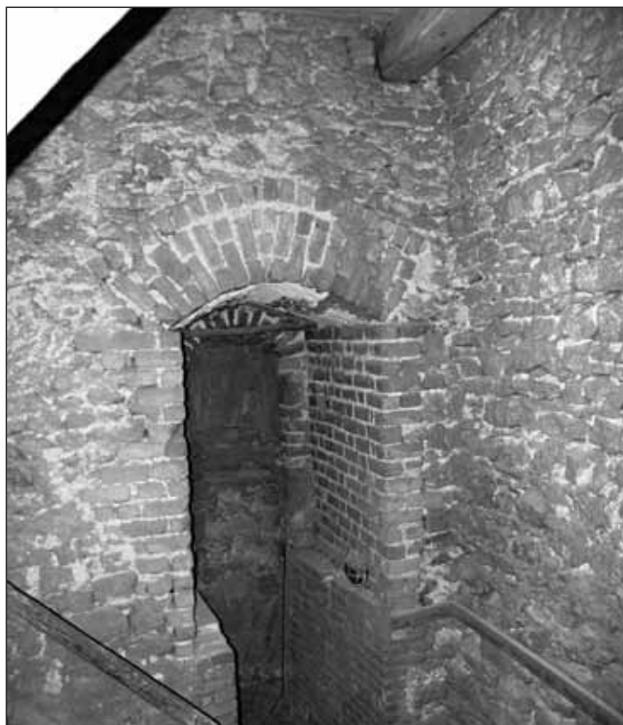
Obr. 12 Římsa v severní stěně věže v úrovni 1NP. Foto archiv Archaia Brno o. p. s. 2004, i. č. 09441-2004.
