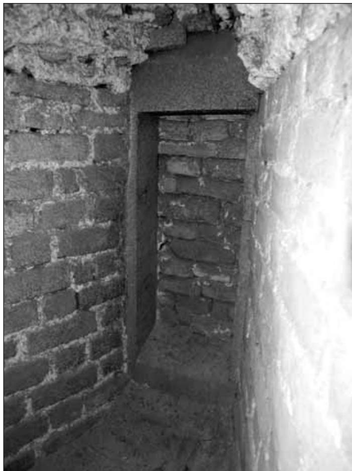
Obr. 17 Detail kamenného ostění okna ve východní stěně 3NP. Foto archiv Archaia Brno o. p. s. 2007, i. č. 09561-2007.
