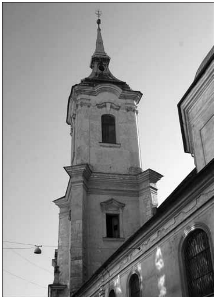
Obr. 8 Celkový pohled na horní partii věže od západu. Foto archiv Archaia Brno o. p. s. 2006, i. č. 11447-2006.
