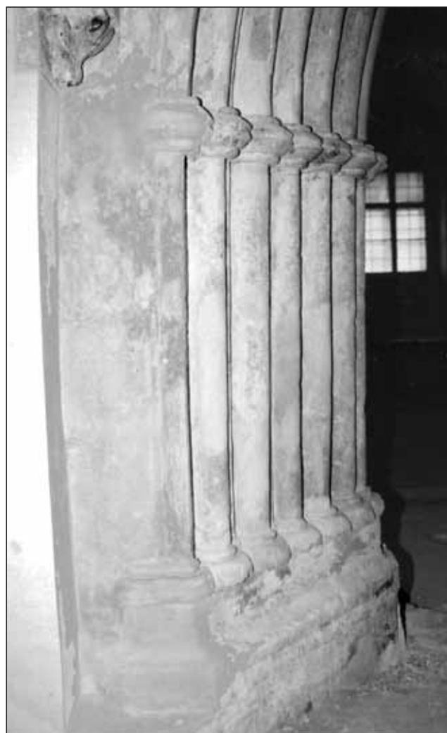
Obr. 6 Brno – minorité. Severní ostění portálu po restaurátorské obnově západní části.
