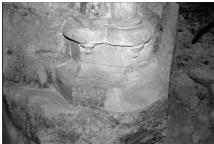
Obr. 7 Brno – minorité. Patky s plastickými konsolkami ve východním úseku jižního ostění portálu (po restaurátorské obnově).
