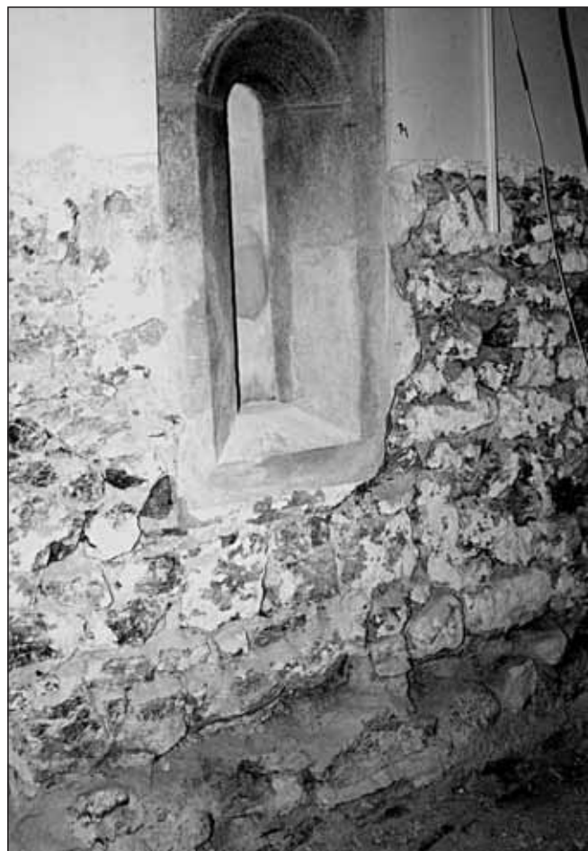
Obr. 16 Brno – dominikáni. Východní stěna románského traktu v západním křídle kvadratury.
