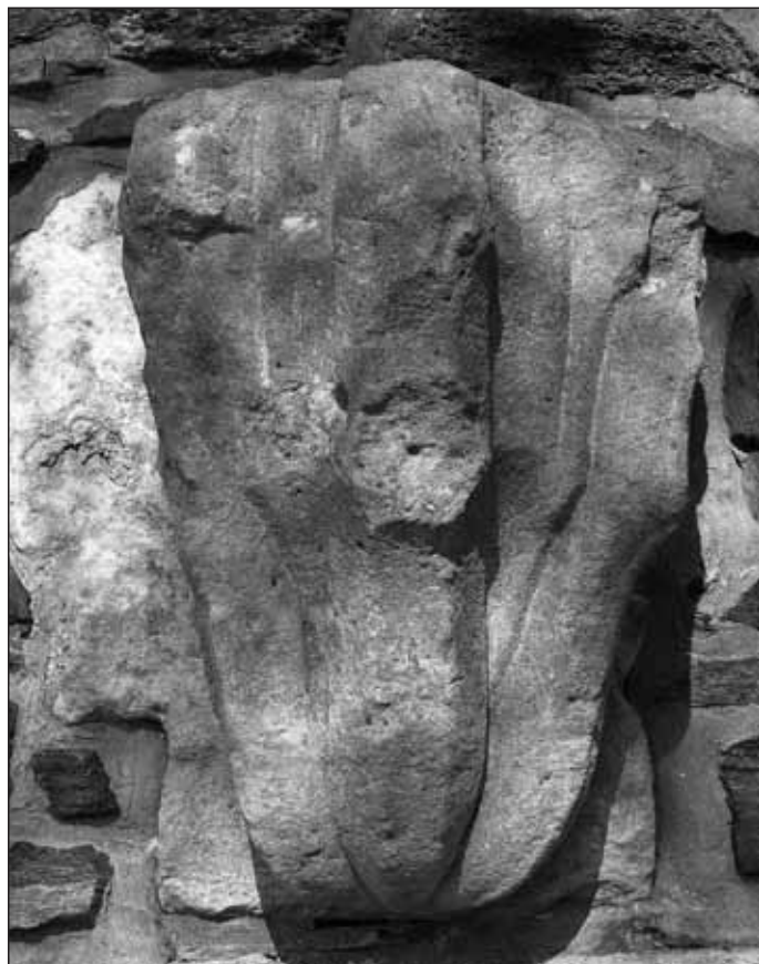
Obr. 1 Klenební konzola s kolenovitým podseknutím v městské hradbě. Foto J. Šanderová.
