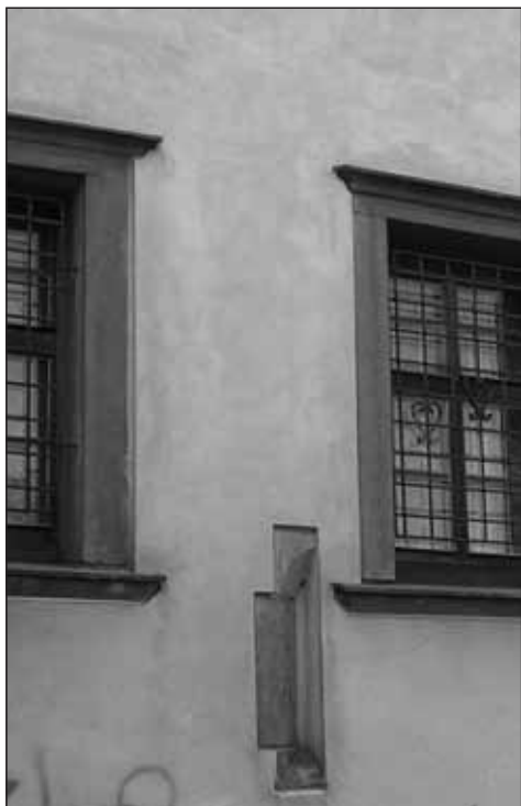
Obr. 11 Část gotického okénka v severní štitové zdi renesančního purkrabství. Foto R. Bláha.
