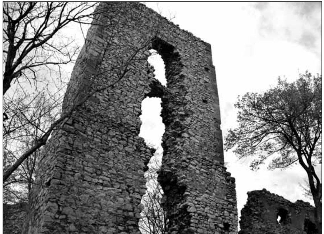
Obr. 11 Východná veža Dobrovodského hradu s nárožiami armovanými kvádrmi z pieskovca. Foto A. Hornáčková 2009.
