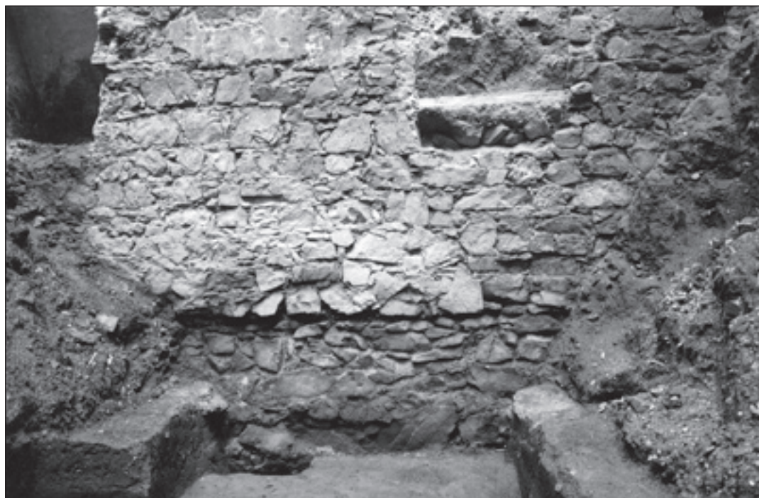
Obr. 3 Vnější líc hradební zdi Starého Města pražského na Národní třídě čp. 973/l. Zcela dole nevysoký základ hradby, zahloubený do starších terénů a oddělený u pravého i levého profilu světlou stavební úrovní s hojnou maltou. Nadzemní zdívo je v dolní části mírně odstupněné a je dochováno v originální podobě z 30. let 13. století, vpravo částečně porušené mladším otvorem až do úrovně kryté omítkou. Pohled od jihu.
