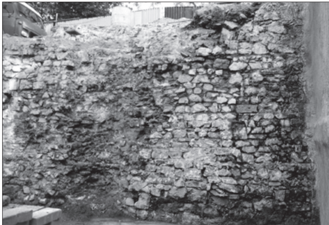
Obr. 2 Vnitřní líc hradební zdi Starého Města pražského v Divadelní ulici čp. 322/1 z 50. let 13. století. Vlevo jízva po odbourání dodatečně přizděné, částečně do zdiiva hradby vlámané jímky. Pohled od východu.
