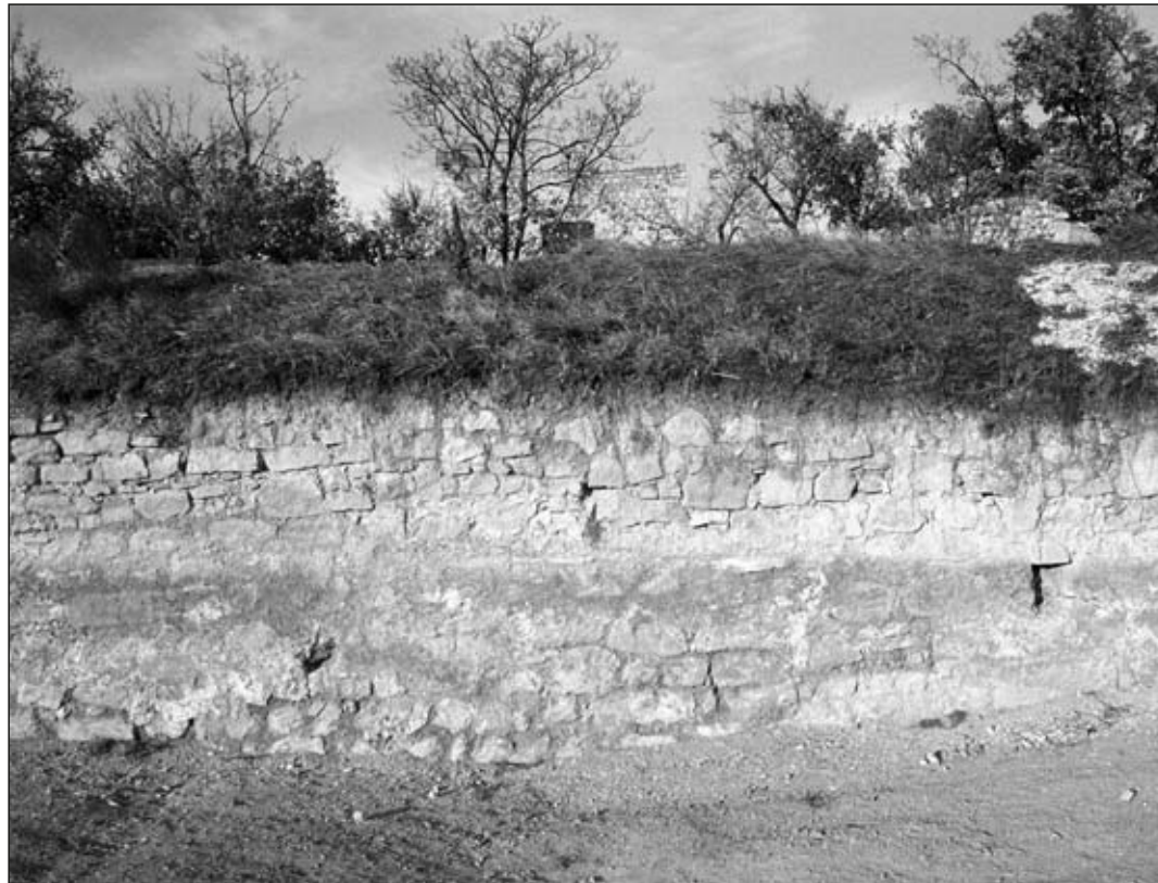
Abb. 7 Detailaufnahme jenes Abschnittes der südlichen Ringmauer aus dem 13. Jhdt., in dem Seebach und Schicht einen primären Flankierungsturm voraussetzen, nach der Abtragung fast des gesamten Komplexes an spätmittelalterlich-(früh)neuzeitlichen Aufschüttungsschichten des Südzwingers im Sommer 2000.
