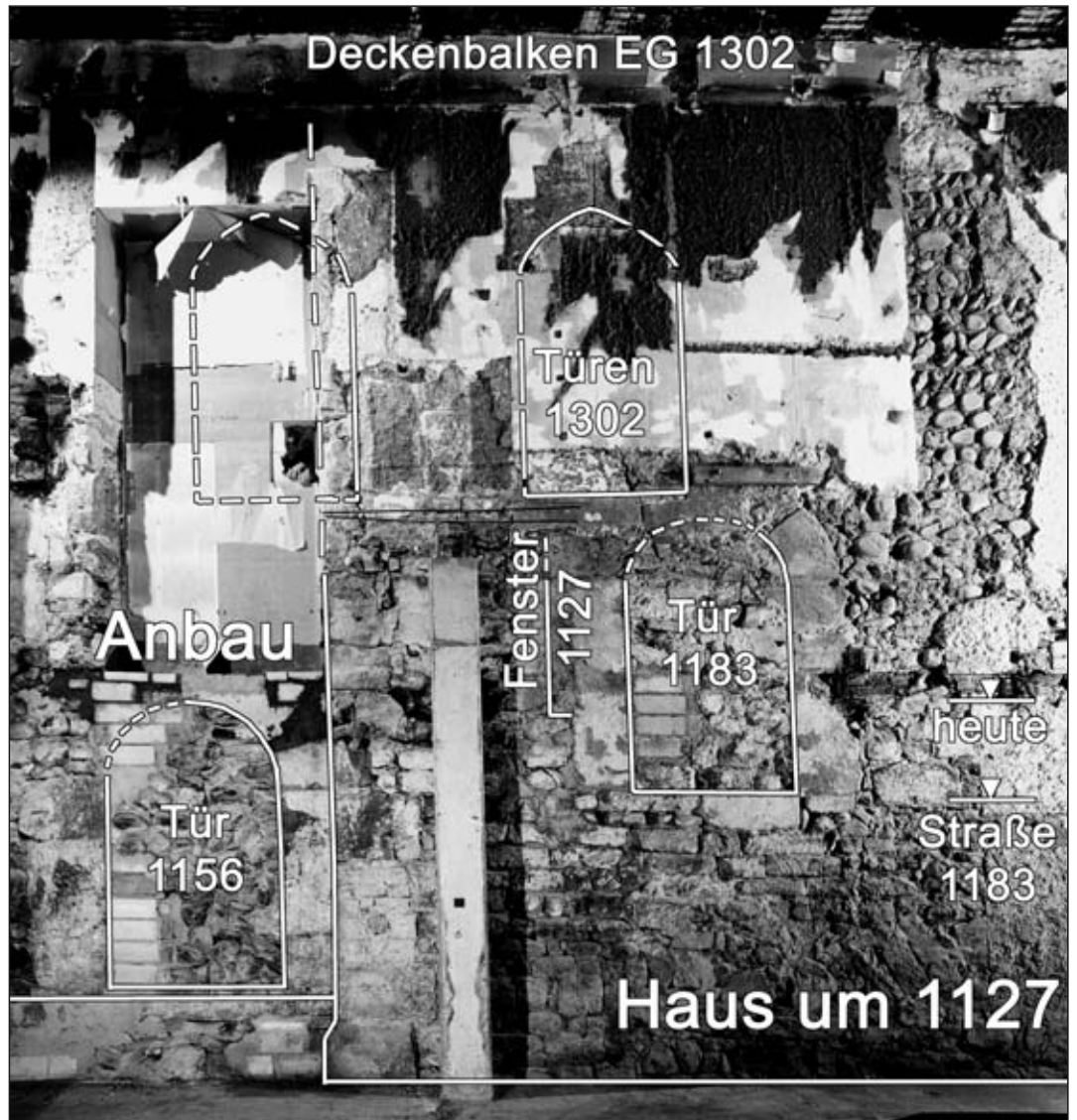
Abb. 5 Baubefunde im Haus „zum Roten Basler Stab“ (Salzstraße 20). Seitenwand des um 1127 errichteten Steinbaus mit Quaderecke, Kleinquader- und Wackenmauerwerk. Hofseitiger Anbau mit Tür und weitere, nach der Straßenaufschüttung eingebrochene Türen.
