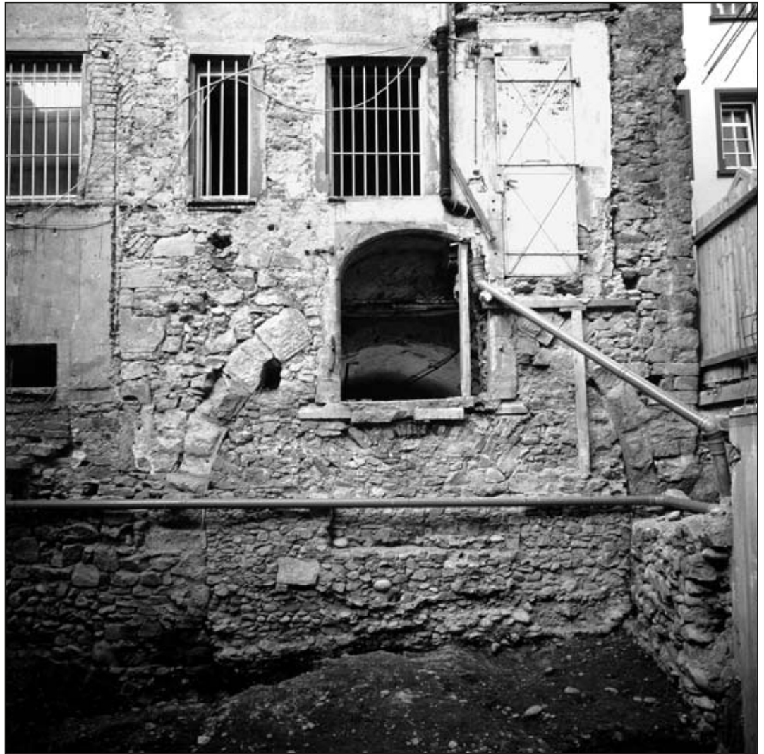
Abb. 10 Ehemaliger rundbogiger Kellerzugang vom Hof aus, später vermauert und durch eine höher sitzende Tür ersetzt (Salzstraße 20).
